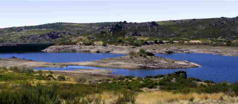
Barragem da Serra Serrada
